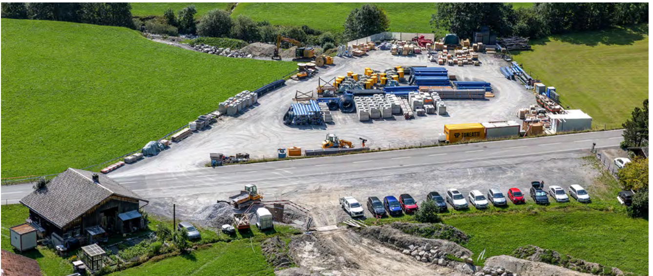
Materialumschlagplatz der Baustelle FUTURO
